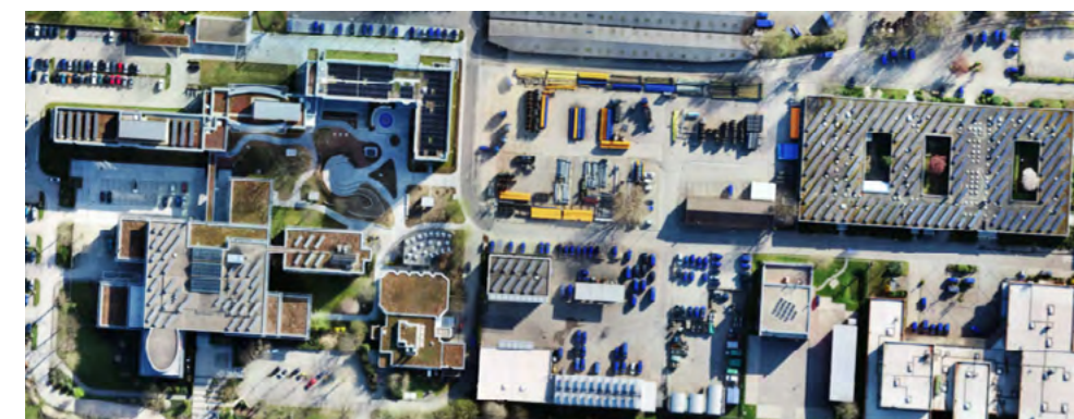
Hauptstandort Freiburg im Industriegebiet Nord mit Verwaltungsgebäuden, Sozialgebäude mit Kantine, Lager und Werkstätten.<
