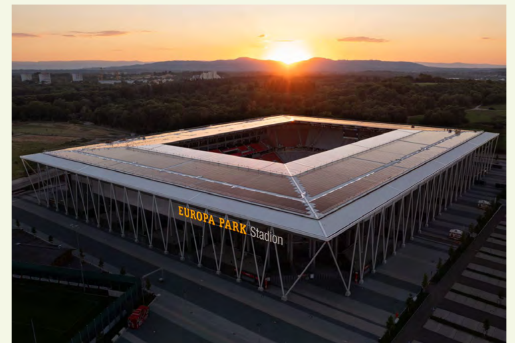
Solardach des Europapark-Stadions: die 2,4 Megawatt-Anlage gilt als Deutschlands größtes Solardach auf einem Fußballstadion (Mitte)
